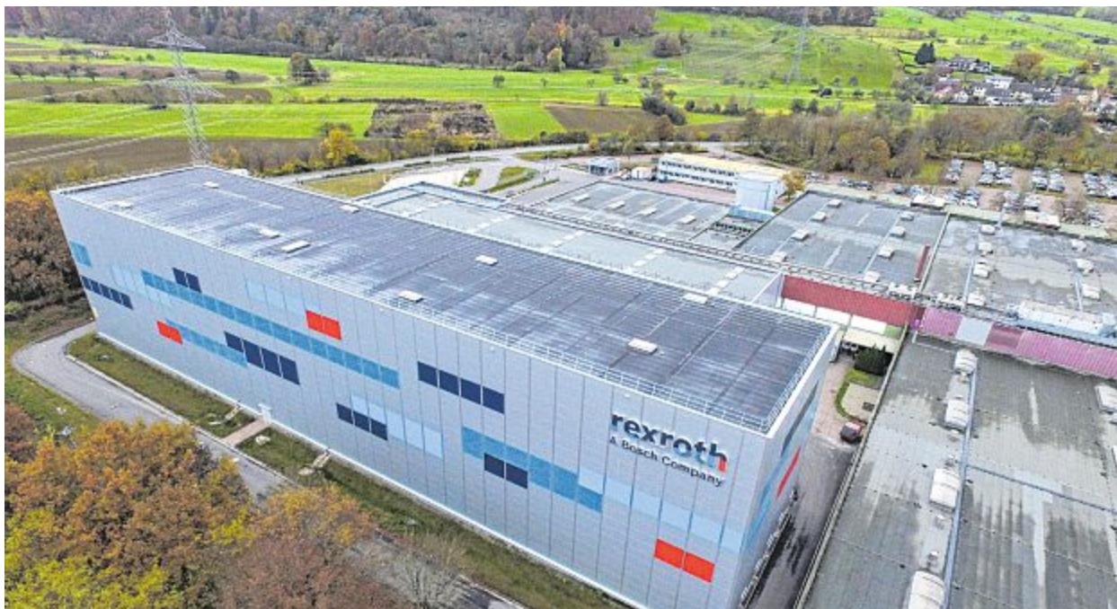
Das neue Logistikzentrum von Bosch Rexroth im Lohrer Industriegebiet Süd wurde 2024 in Betrieb genommen und ist auf dem neuesten Stand der Technik. Foto: Johannes Ungemach
